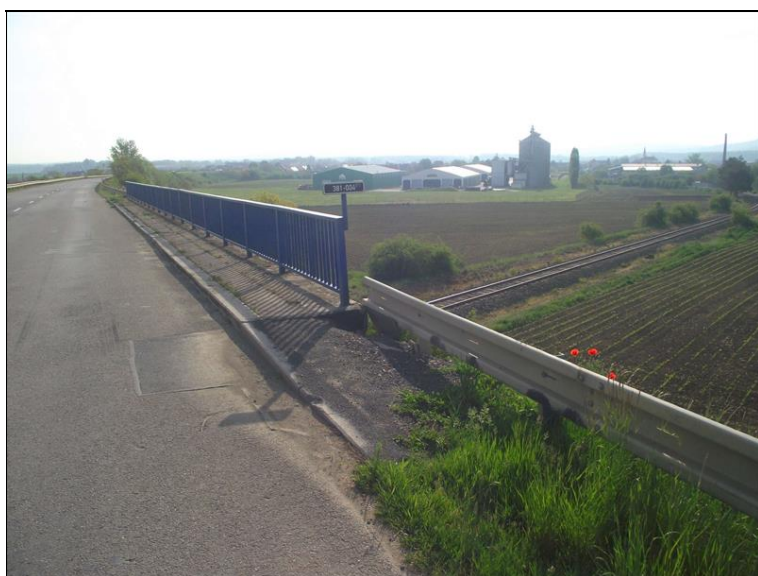
Detail špatného napojení svodidla na pravé straně opěry OP1.
