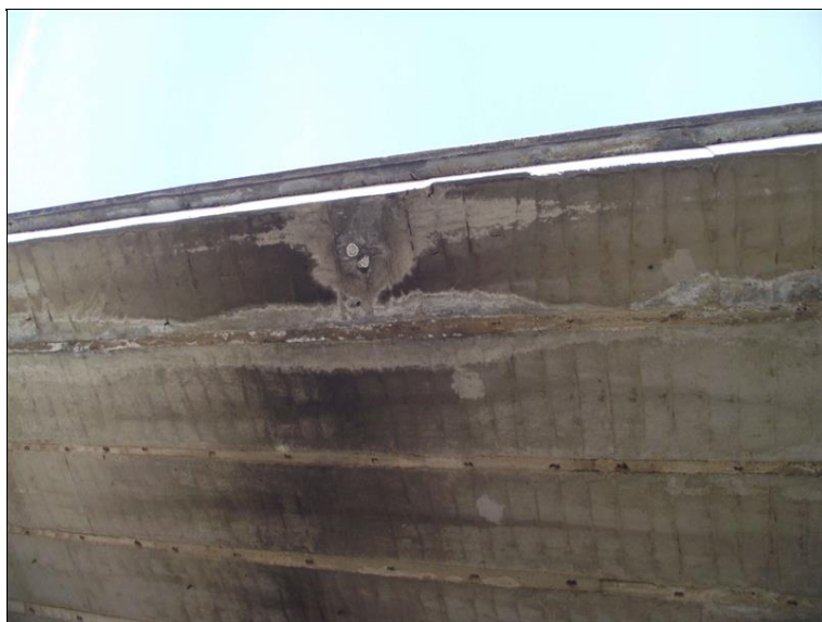
Detail pohledu NK - zřetelné stopy po zatékání mezi krajními nosníky na pravé straně.
