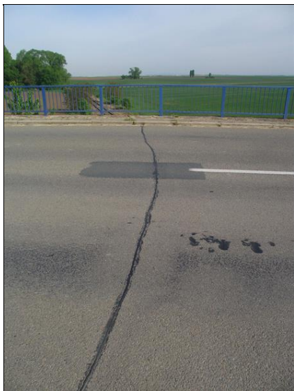
Příčná trhlina ve vozovce v místě uložení u opěry OP1.
