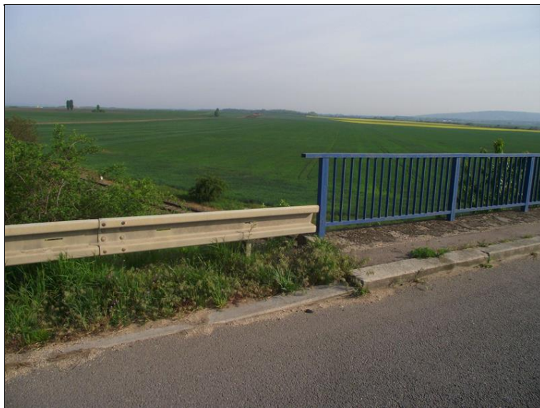
Detail špatného napojení svodidla na pravé straně opěry OP2.
