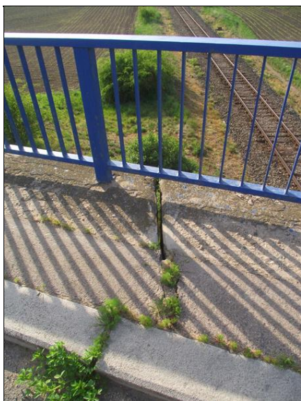
Detail dilatace římsy v místě uložení u opěry OP2 vpravo.
