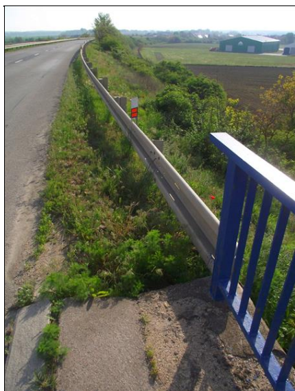
Detail špatného napojení svodidla na pravé straně opěry OP2.
