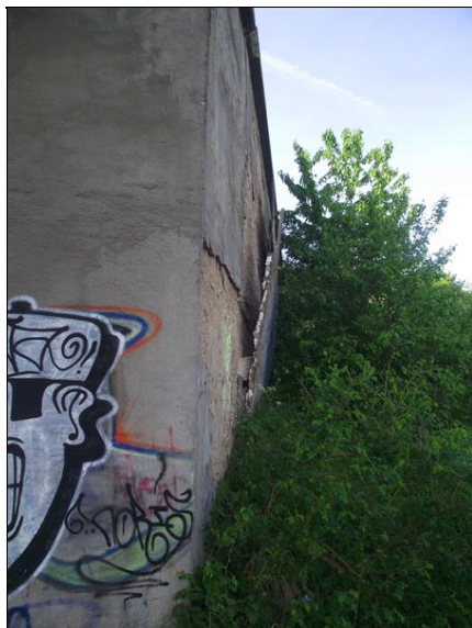
Detail kompletně uvolněného povrchu sanace na levé křídle opěry OP1.
