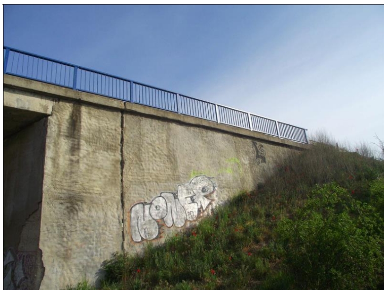
Detail dilatační spáry u křídla u opěry OP2 vpravo.
